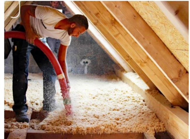
Ein Arbeiter bringt Zellulose als Einblasdämmung auf einem Dachboden ein. Foto: Zimmerer Brönnecke GmbH
