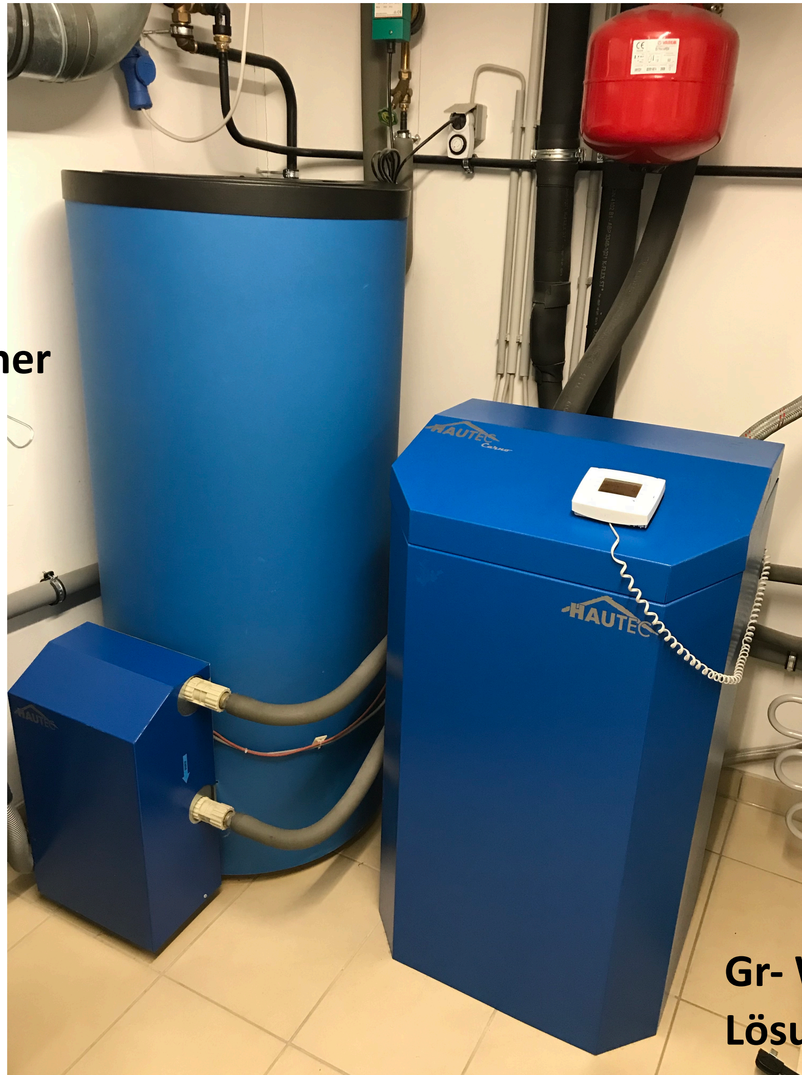
Kl. Wärmepumpe (Rücklauf d. Fussbodenheizung)
