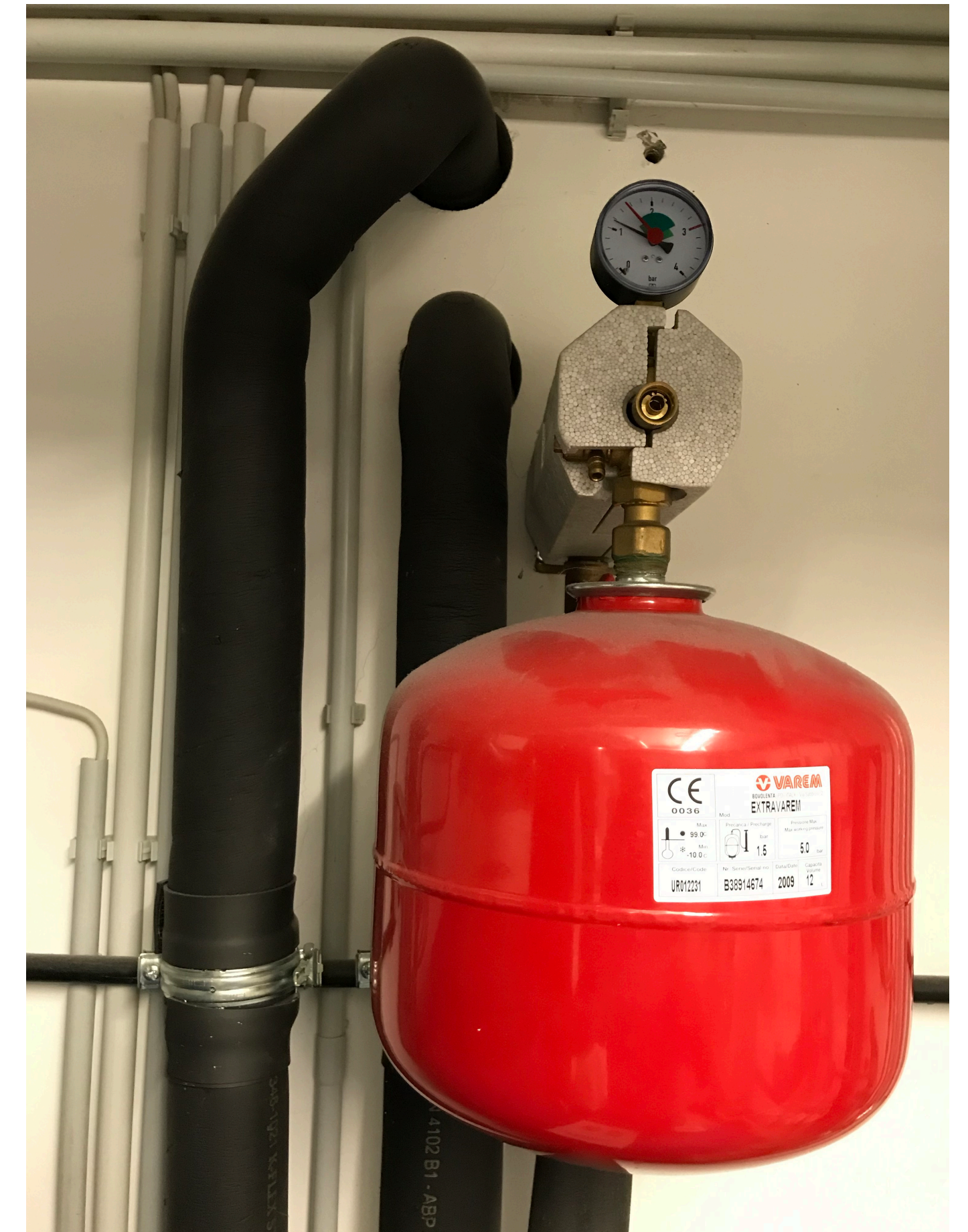
Ein- u. Ausgang der Sole- Lösung - Erdwärme
