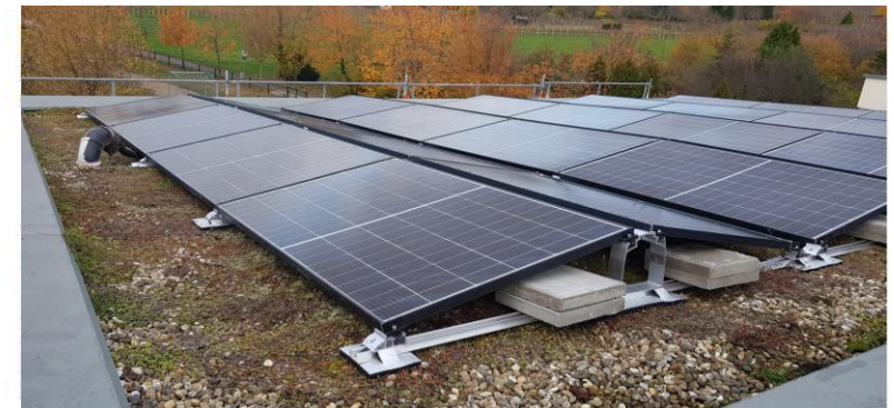
Solaranlage (Ost-West-Ausrichtung)
