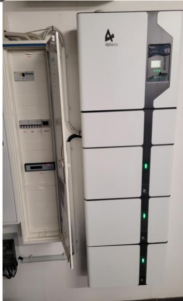
Batteriespeicher mit Schaltschrank
